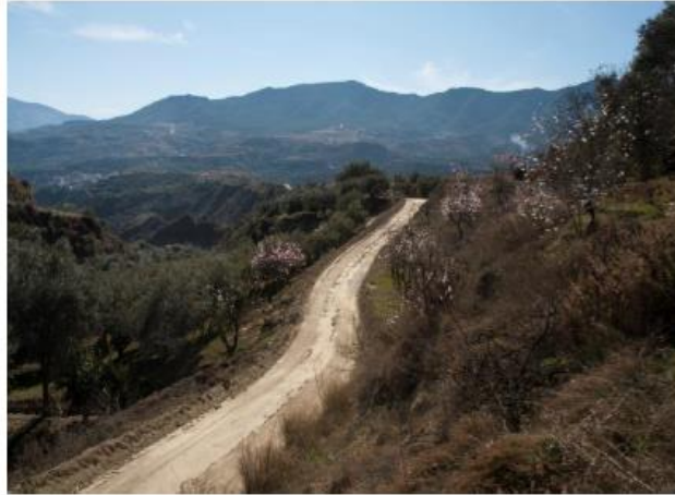
Caminos en Granada antes de las actuaciones
