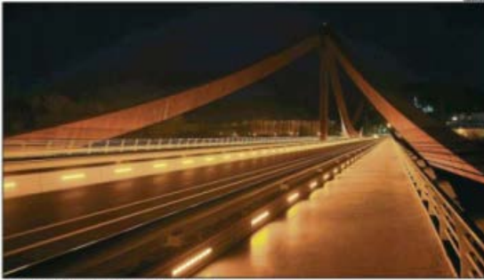
Detall del pont que connecta el barri de Pedret amb l'hospital.
