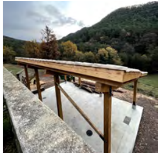
Coberta de la Solana en construcció. Font: Arxiu XPN
