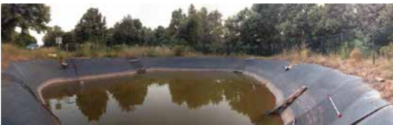
Bassa de prevenció d'incendis de PVC amb diverses rampes de xarxa per permetre la sortida de la fauna (Fotografia: D. Guinart)
