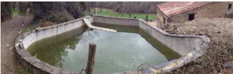
Bassa de rec amb una rampa basculant (Fotografia: D. Guinart)
