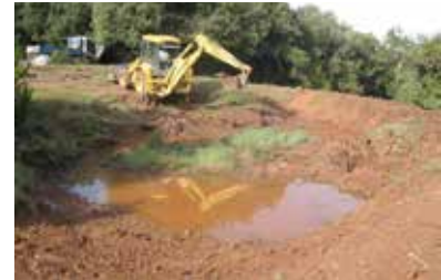
Reparació de la paret de contenció d'una bassa d'aigües pluvials (Fotografia: Ecotons)
