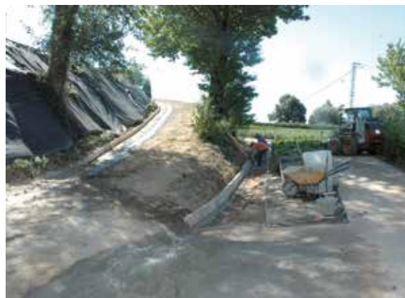
Construcció de cunetes de recollida d'aigües procedents de la pluja i el rec per aspersió en un viver forestal (Fotografia: D. Guinart)
