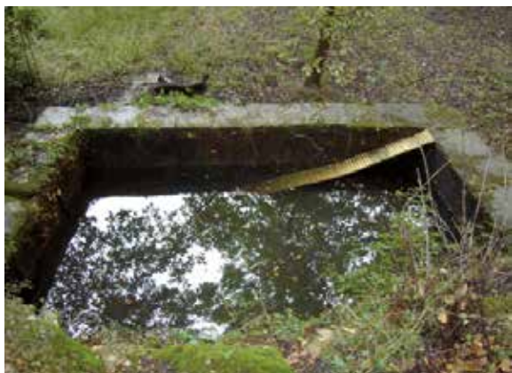
Bassa de rec amb una rampa basculant (Fotografia: D. Guinart)
