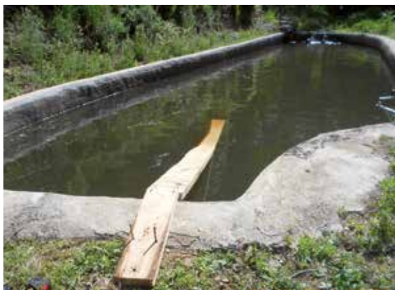
Bassa de rec amb rampa de sortida per al fauna i boies de tancament d'entrada d'aigua (Fotografia: D. Guinart)
