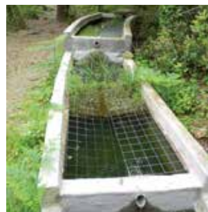
Arques de cria, construïdes expressament per allotjar el cranc de riu del Montseny (Fotografia: D. Guinart)
