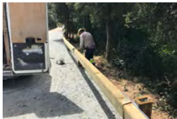
Instal·lació de barana de seguretat. Font: Arxiu XPN
