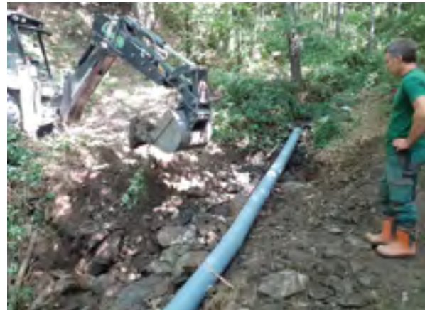
Treballs de restauració de passos d'aigua en camins. Font: Arxiu XPN
