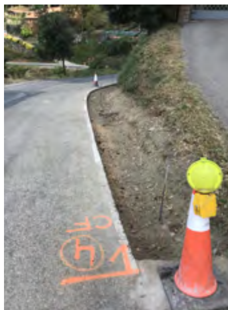
Millora de la pista a la Costa del Montseny. Font: Arxiu XPN
