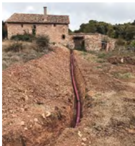
Soterrament línia elèctrica. Font: Arxiu XPN
