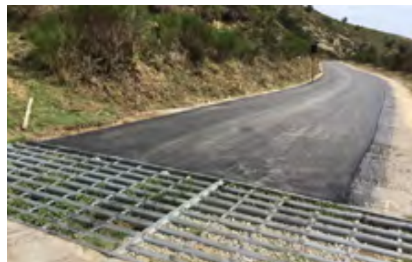
Millora de la pista de Penyacans a Plana Amagada. Reixa ramadera. Font: Arxiu XPN
