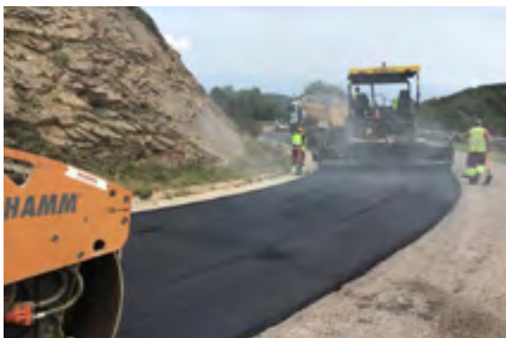
Millora de la pista de Penyacans a Plana Amagada. Formació del paviment. Font: Arxiu XPN
