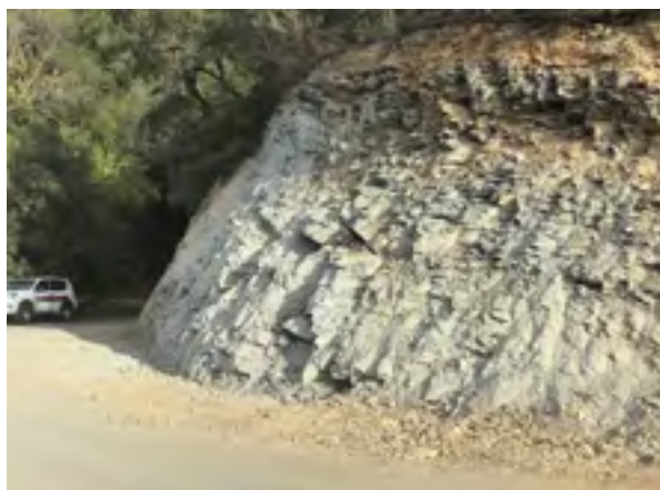
Millora de la pista a la Costa del Montseny. Font: Arxiu XPN
