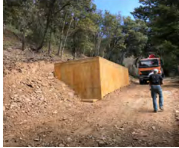
Dipòsit finalitzat després d'aplicar el sulfat de ferro Font: Arxiu XPN
