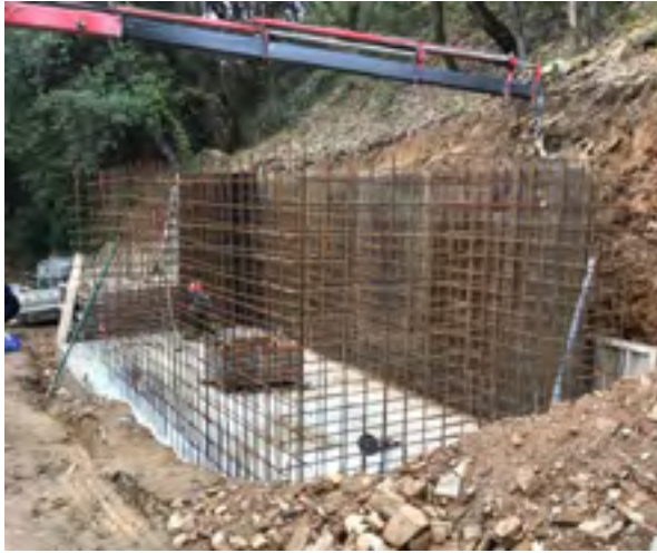
Construcció de l'estructura del dipòsit. Font: Arxiu XPN
