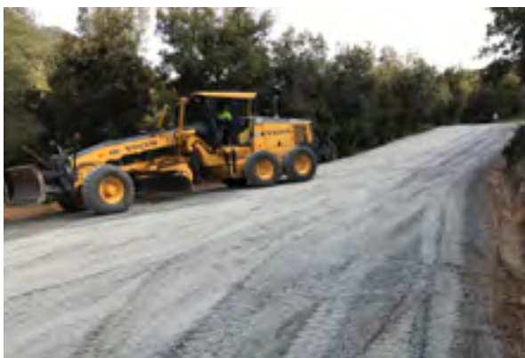
Perfilat del camí i estesa de capa de tot-u. Autor: Font: Arxiu XPN
