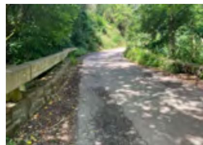
Instal·lació d'una barana de seguretat a la pista de Vallcàrquera 1. Font: Arxiu XPN
