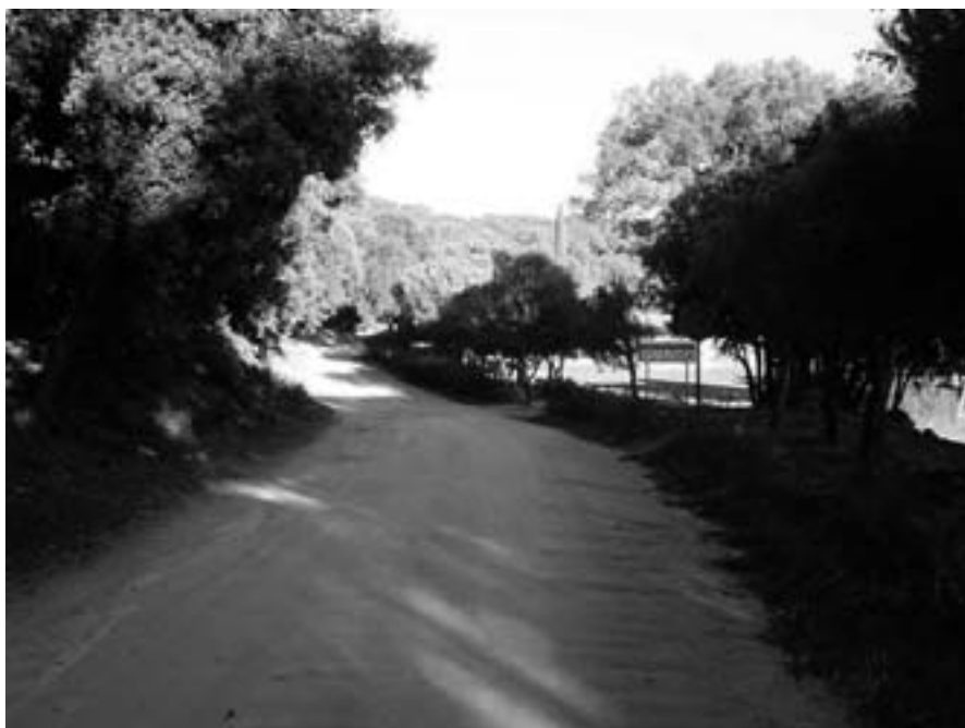
Detall d'un tram de la pista del Corredor al pas per l'Àrea d'Esplai
