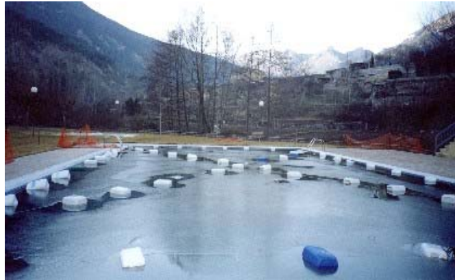
Piscina amb bidons de protecció per les gelades
