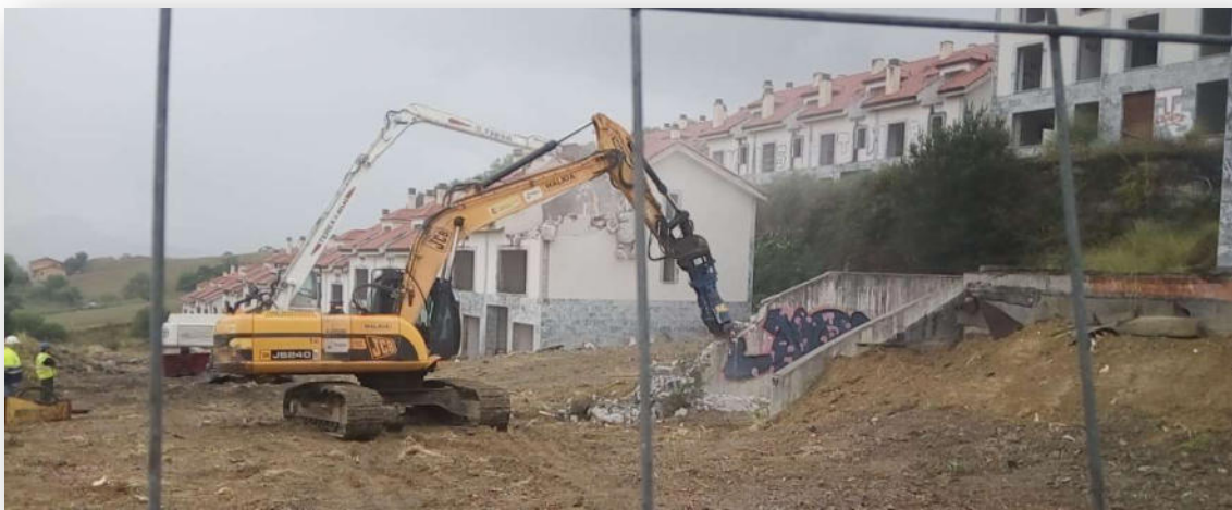
Enderrocament d'una urbanització a Cantàbria
