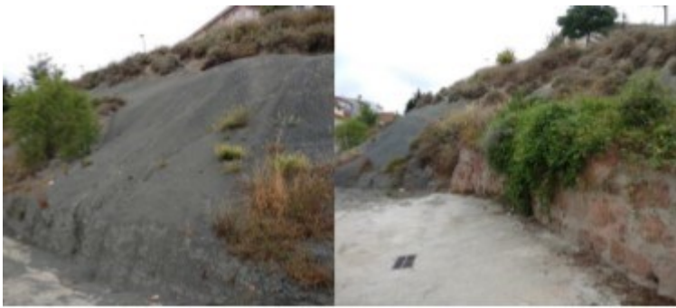
Talús del carrer de la Tossa de Santa Margarida de Montbui
