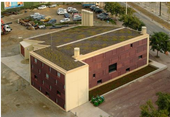
Imatge 9. Coberta verda a la central de RPRSU Diagonal-Poblenou
