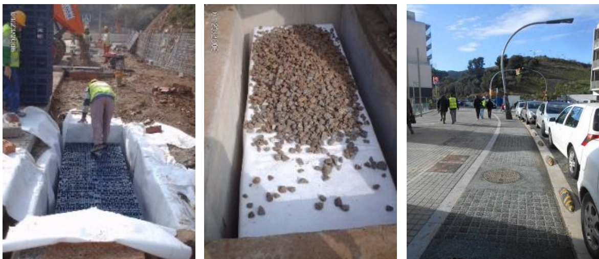
Imatge 4. Construcció i acabat de dipòsit de detenció a Torre Baró.
