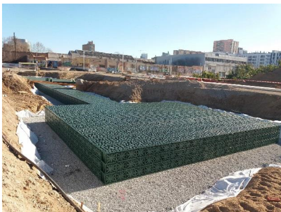
Imatge 17. Construcció de dipòsit d'infiltració a ca l'Alier.
