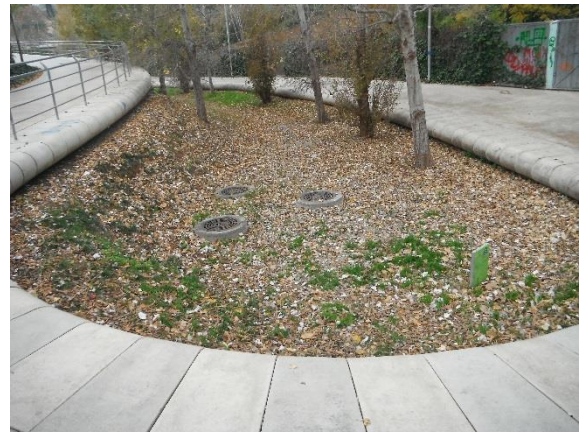
Imatge 14. Parterre inundable al Torrent de les Monges
