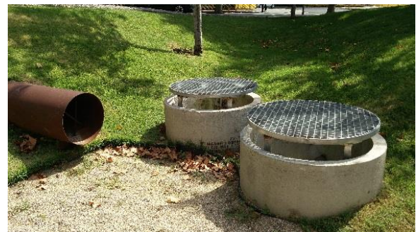
Imatge 28. Pou sobreeixidor a Can Cortada
