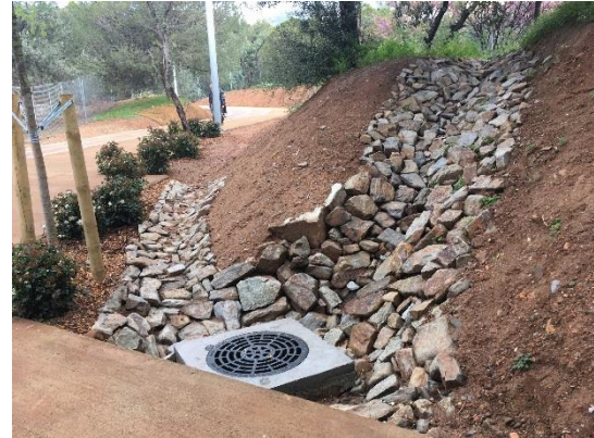
Imatge 22. Cuneta drenant al carril bici Av. Diagonal.
