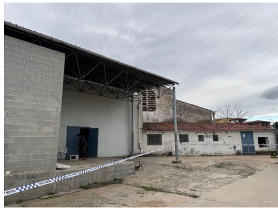
Vista de l'edifici amb l'annex per la part posterior
