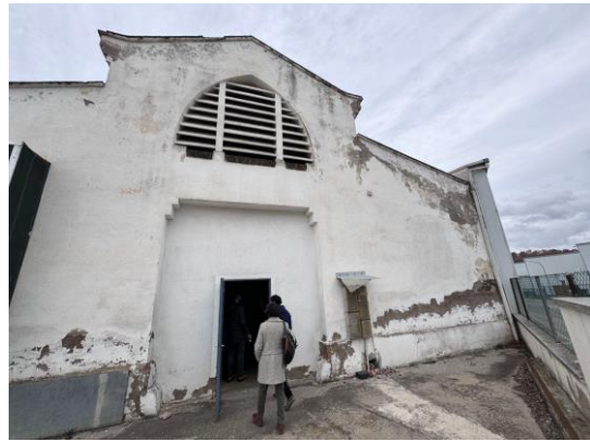
Entrada directa des del carrer a l'edifici patrimonial
