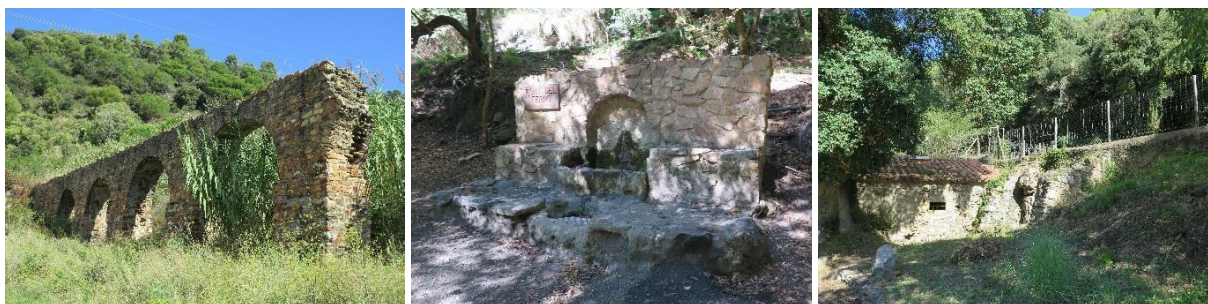
Patrimoni lligat a l'aprofitament de la riera de Pineda: aqueducte romà, font del ferro i molí fariner. Font: ERF-Energia i Sostenibilitat.
